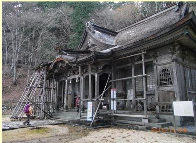
修理中の本殿
