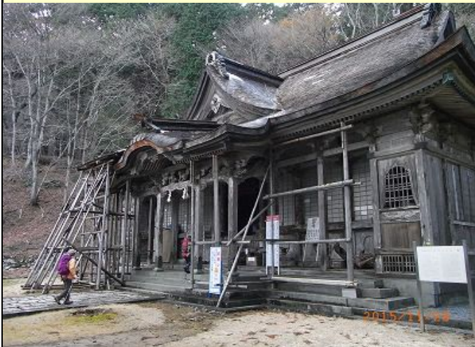
修理中の本殿
