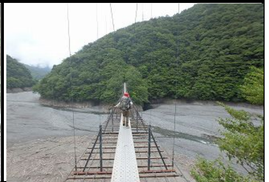
畑薙大吊橋 橋長約181m、歩道部約0.4m 大井川の水面から約30m。スリル満点！
